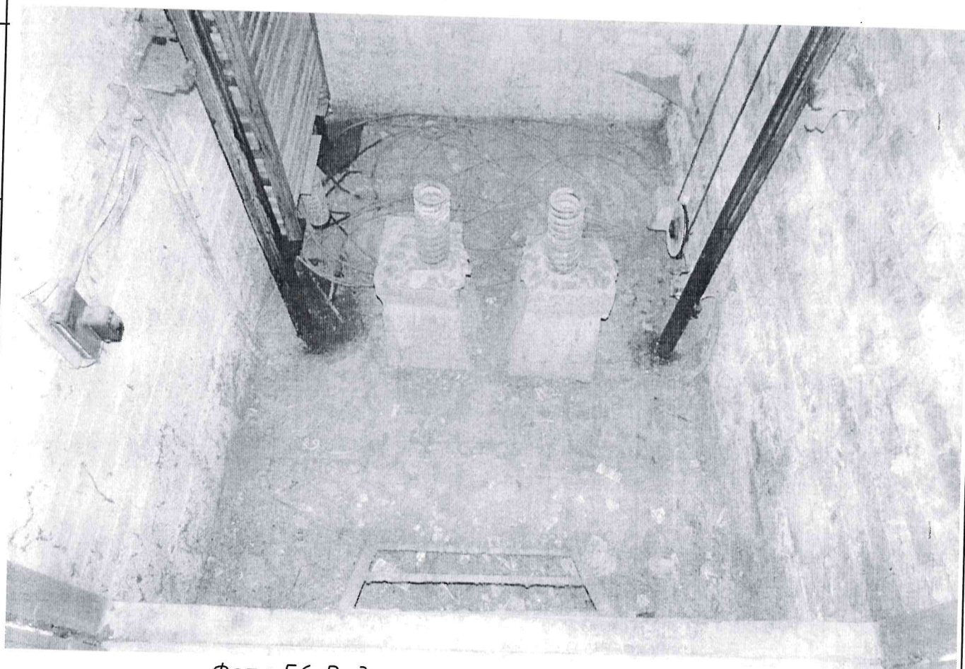
Фото Б6. Вид на приямок лифтовой шахты
