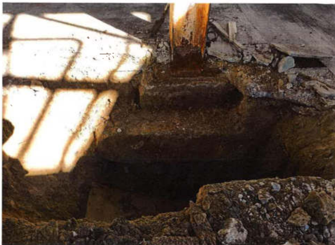
Фотография 2.7 – Шурф №1 по оси «101» ряда «ГГ»
