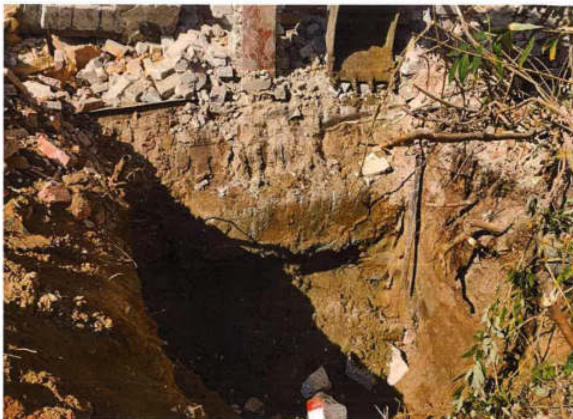
Фотография 2.9 – Шурф №3 по оси «91» ряда «НН»
