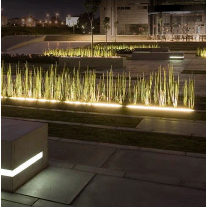
ВСТРОЕННЫЕ В МОЩЕНИЕ СВЕТИЛЬНИКИ
