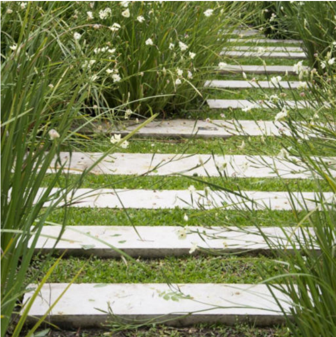
ШАГОВАЯ ДОРОЖКА ИЗ БЕТОННЫХ ПЛИТ от благоустроенной зоны к зоне дикой природы
