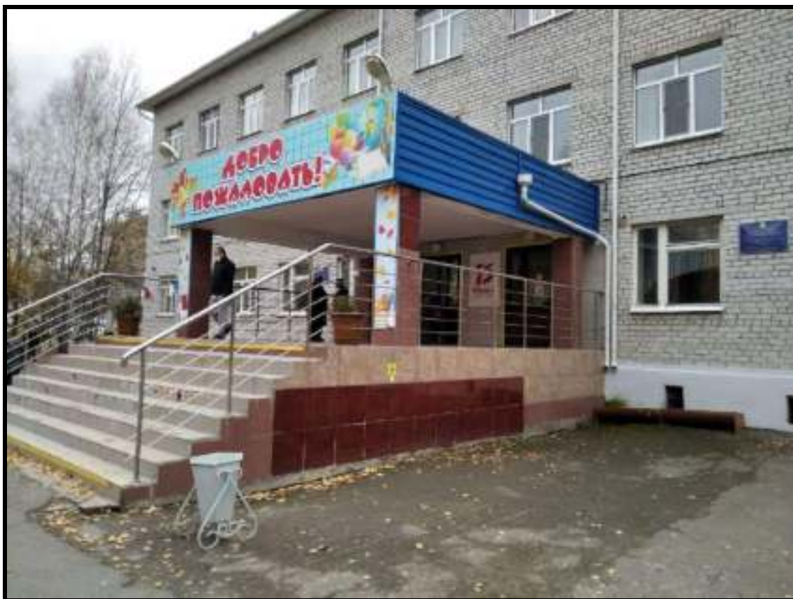
Фото 1 – Общий вид главного входа здания школы
