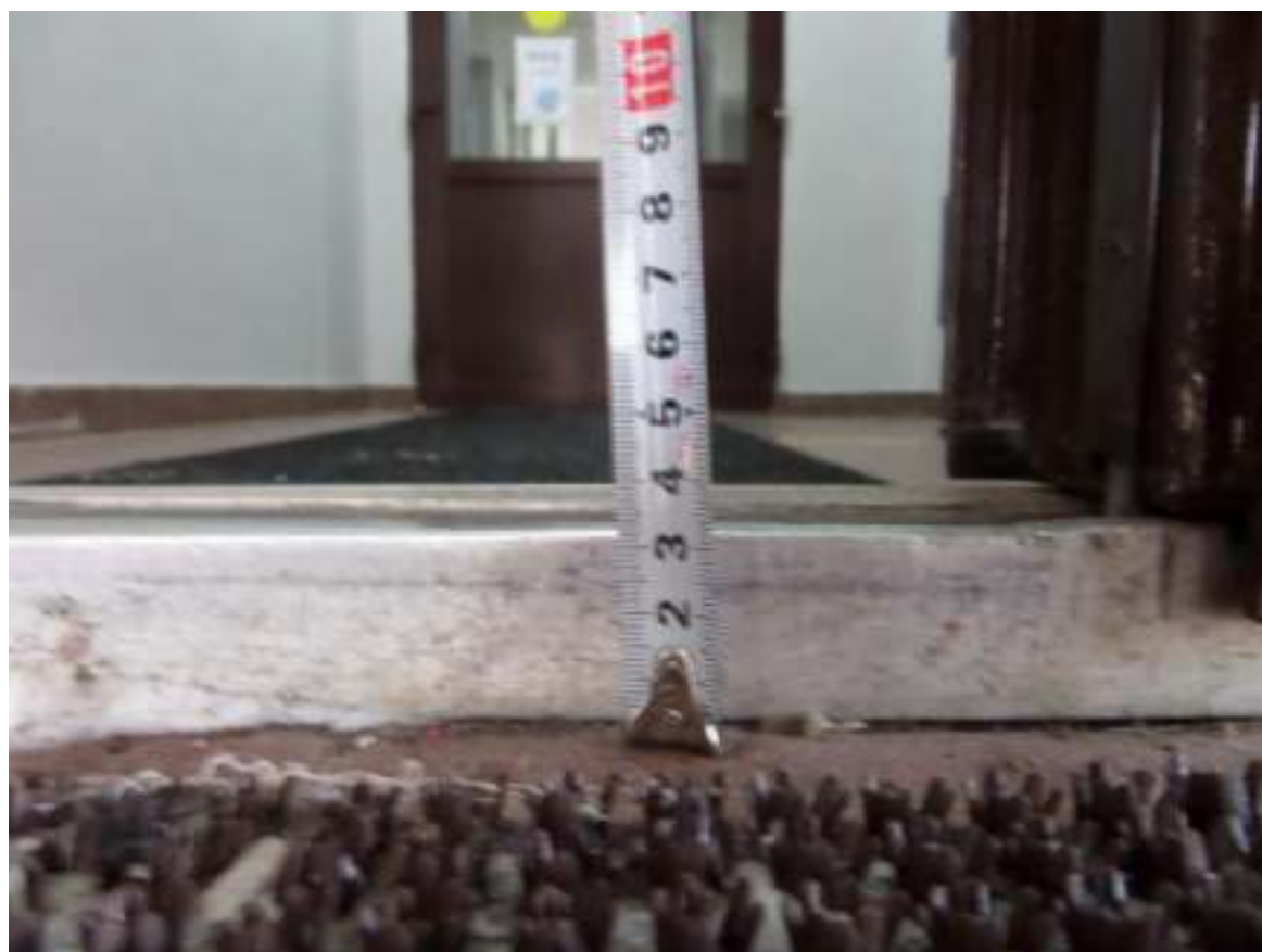
Фото 9 – Порог наружной двери
