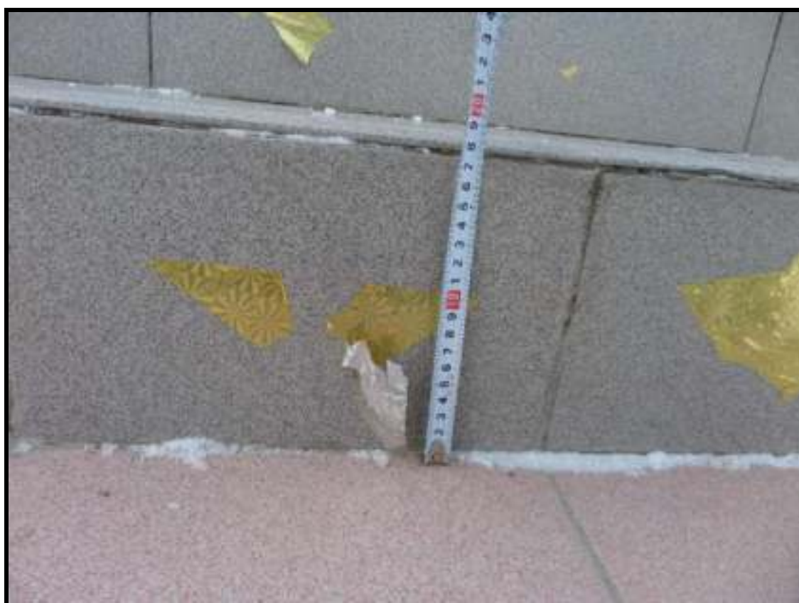
Фото 2, 3 – Высотные размеры ступеней
