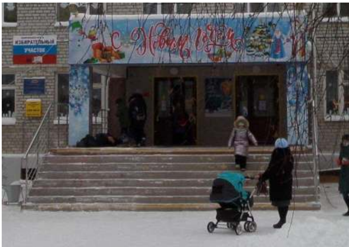
Фото 8 – Отсутствие разделительного поручня и пандуса.
