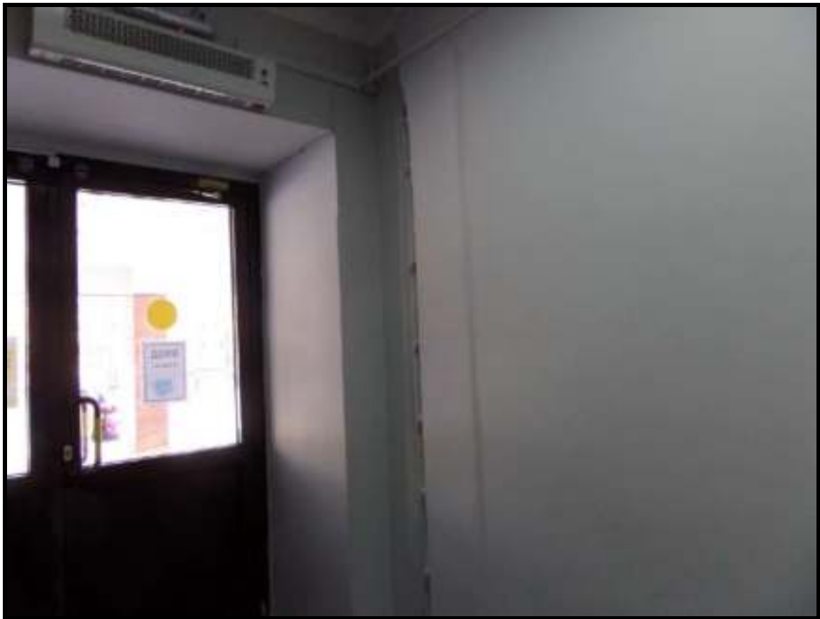
Фото 6, 7 – Тамбур с вентиляционными продухами
